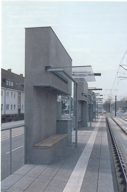
Bei drei der insgesamt zwölf Haltestellen setzten die Architekten bei der Oberflächengestaltung auf Metall. Auf dem Weg aus der Innenstadt zunächst an der hier gezeigten Haltestelle Kerstingstraße (gedoppeltes Edeltahlgewebe) . . .
