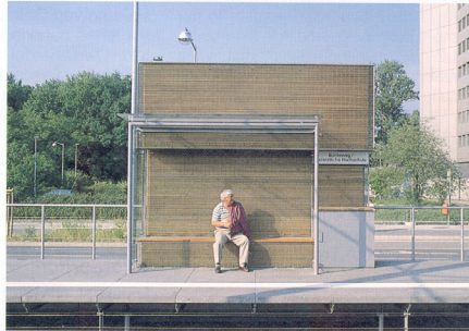
. . . sowie an der bereits vorgestellten Haltestelle Lange-Feld-Straße und weiterhin an der Haltestelle Buntweg (industriell gefertigte Stahlgitter im Abstand von 10 cm zu naturbelassenen Lärchenholz).
