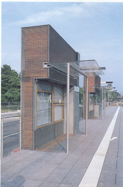
. . . sowie an der bereits vorgestellten Haltestelle Lange-Feld-Straße und weiterhin an der Haltestelle Buntweg (industriell gefertigte Stahlgitter im Abstand von 10 cm zu naturbelassenen Lärchenholz).
