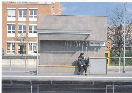
Bei drei der insgesamt zwölf Haltestellen setzten die Architekten bei der Oberflächengestaltung auf Metall. Auf dem Weg aus der Innenstadt zunächst an der hier gezeigten Haltestelle Kerstingstraße (gedoppeltes Edeltahlgewebe) . . .
